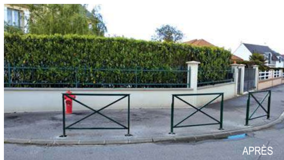
Pose de 3 barrières pour empêcher le stationnement au niveau de la borne incendie sur le trottoir de la rue Rose Villin.
