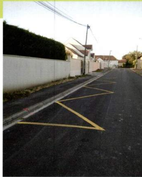
Création d'un arrêt de bus Arthur Chaussy
