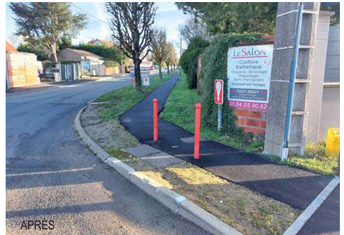
Réfection partielle de l'allée piétonne rue du Maréchal Galliéni entre les feux tricolores et l'abri bus
