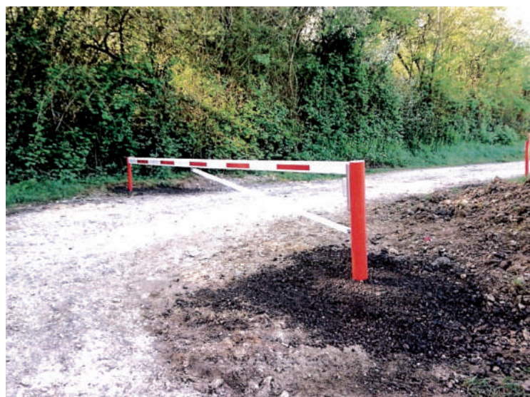
Installation d'une barrière sur la voie communale N°4 d'Evry-les-Châteaux à Suisnes
