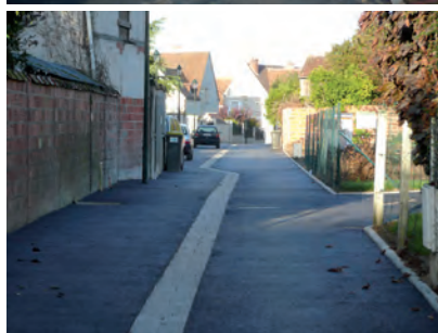
réfection de la ruelle de Chérelles
