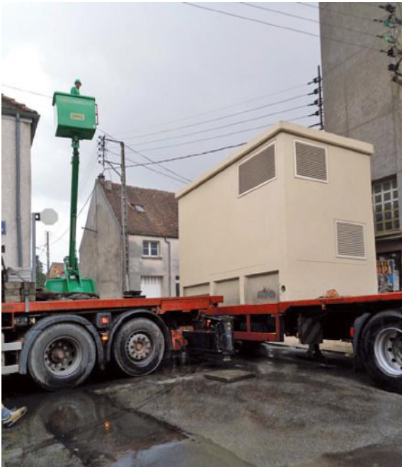
Enfouissement des réseaux rues Sadi Carnot - Mme Hégot - Libération (livraison du nouveau poste électrique)
