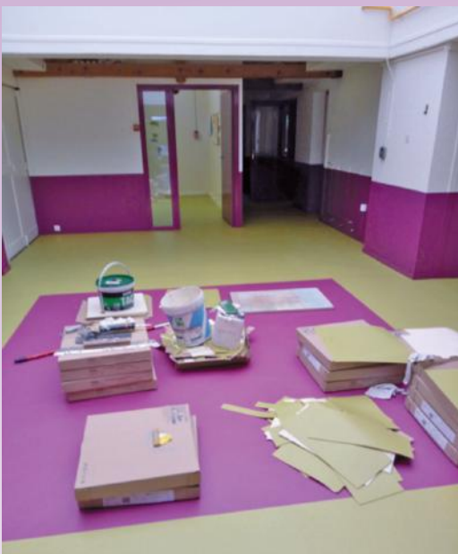
Travaux dans les écoles : Pose d'un nouveau revêtement de sol (école Champ Fleuri)
