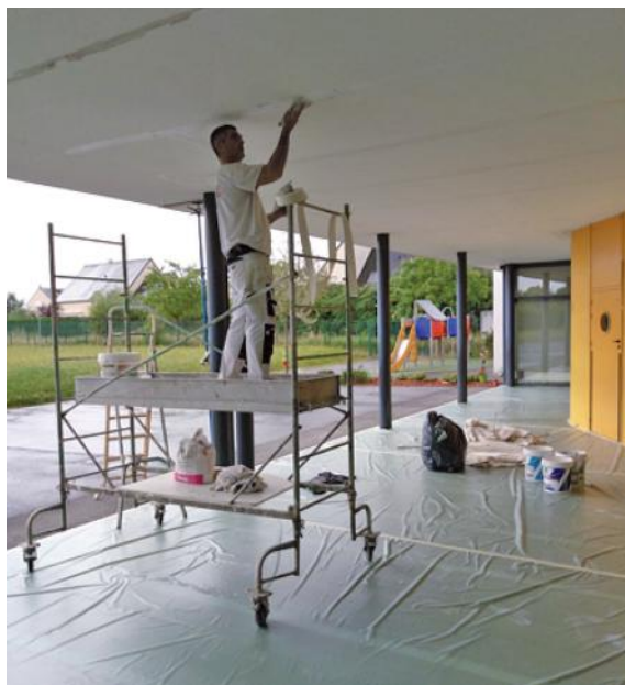
Réfection du plafond de la maternelle
