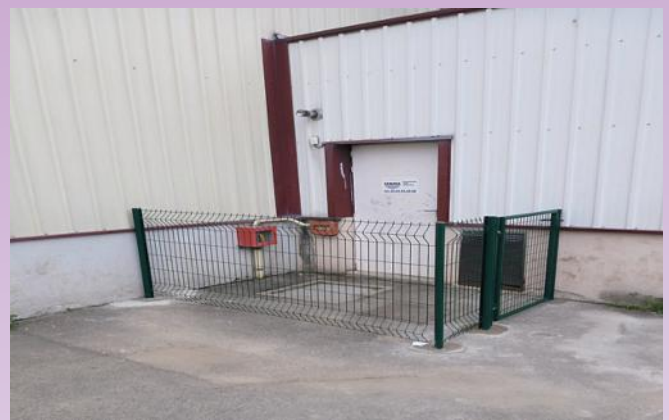
Sécurisation de la cour de l'élémentaire (vanne gaz)
